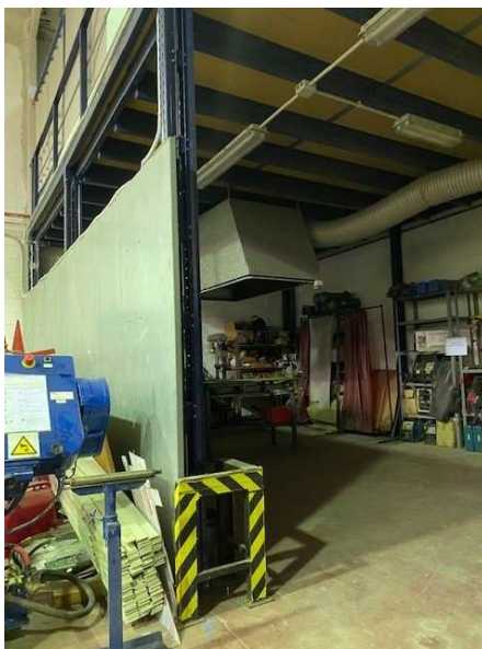
Protección de vigas attillo del fondo
