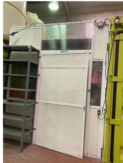
Conexionado eléctrico contenedores
