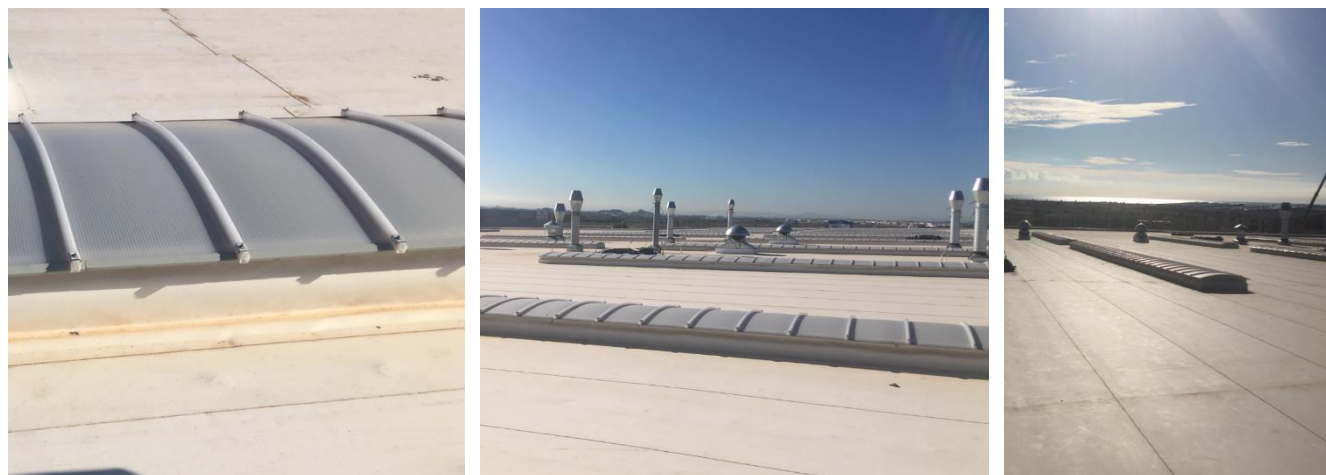
Tipo de placa translúcida en la cubierta de la nave
