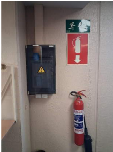
CUADRO ELECTRICO CORTE GENERAL DE ALUMBRADO JUNTO A ESCALERAS EN RECEPCION. SECTORIZACION PLANTA OFICINAS.
